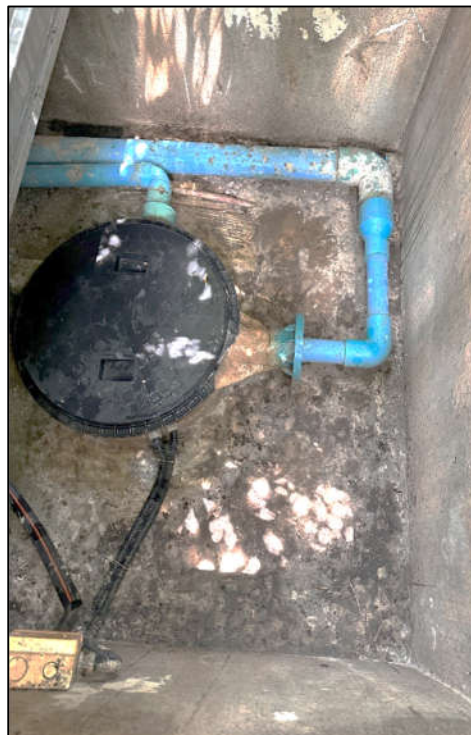
ภาพที่ 44 แสดงถังเก็บน้ำสำรองใต้ดิน
