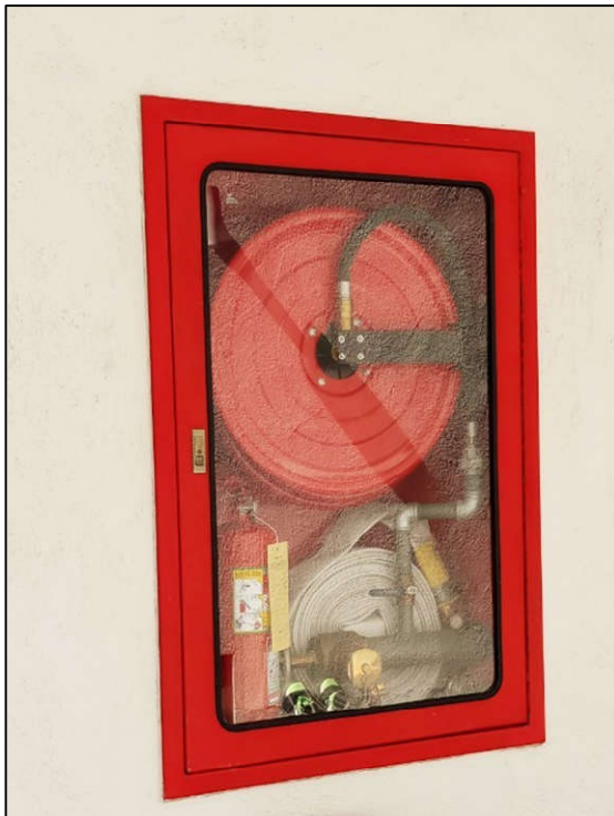
ภาพที่ 27 แสดงตู้อุปกรณ์ดับเพลิง & วิธีการใช้งาน
