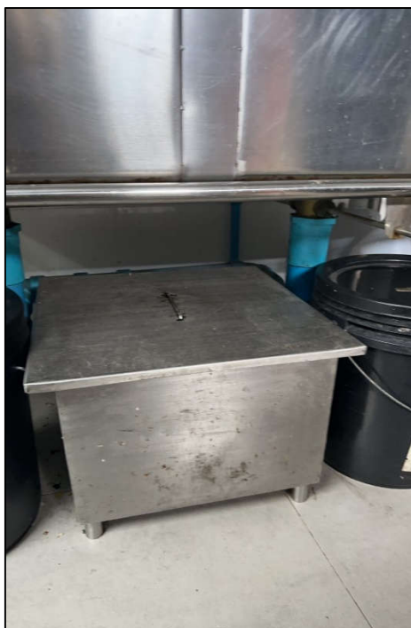
ภาพที่ 36 แสดงบ่อดักไขมันภายในห้องครัว
