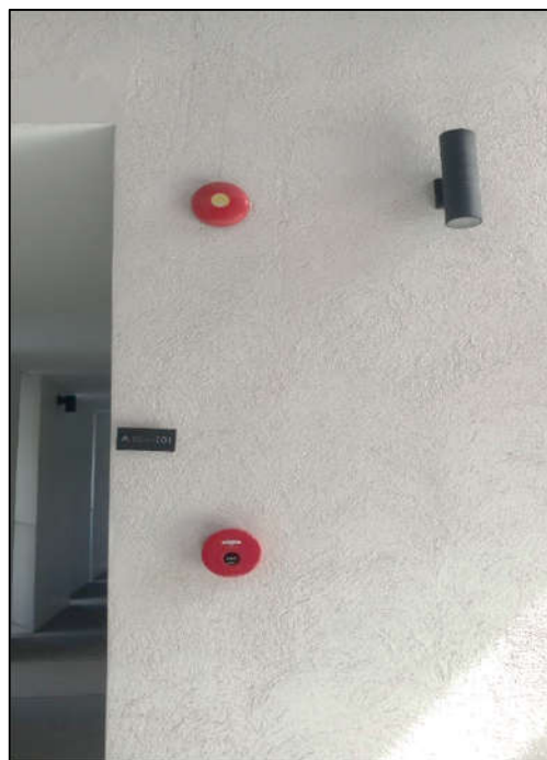
ภาพที่ 26 แสดงระบบสัญญาณเตือนไฟไหม้ (Fire Alarm System)
